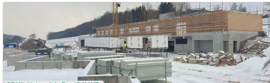
ASZ Vöcklabruck in Bau, BAV VB
