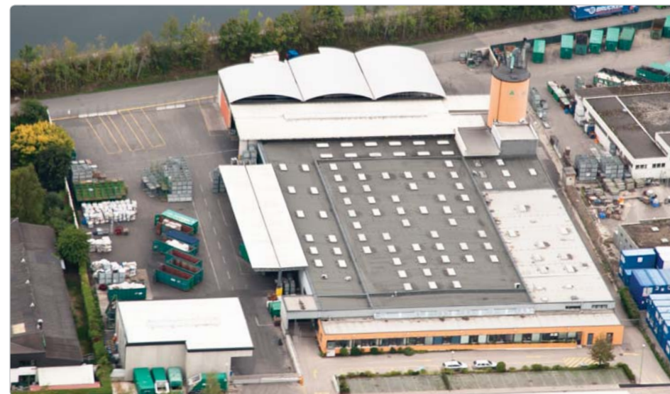
Abfall-Logistikzentrum in Wels
