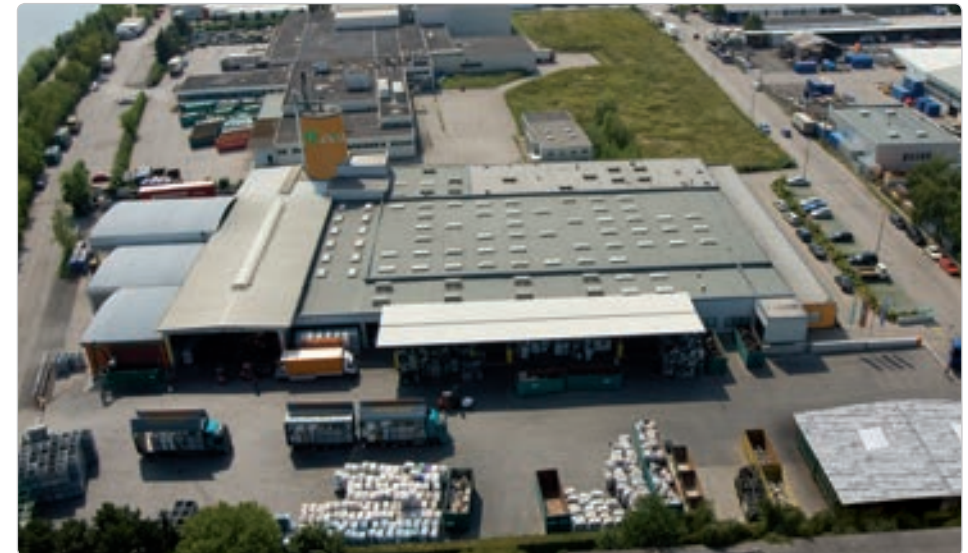
Abfall-Logistikzentrum in Wels
