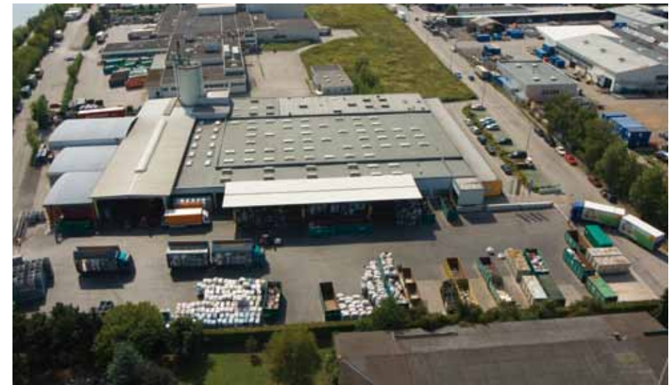
Abfall-Logistikzentrum in Wels
